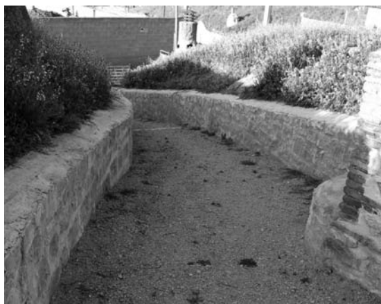
Muretes de contención en una senda.
