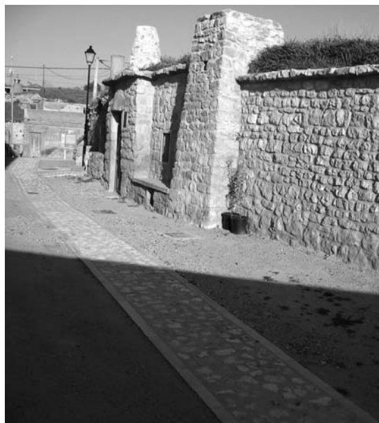
Exterior de la Bodega Vecinal.
